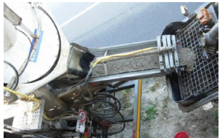
Trasporto tramite autobetoniera
