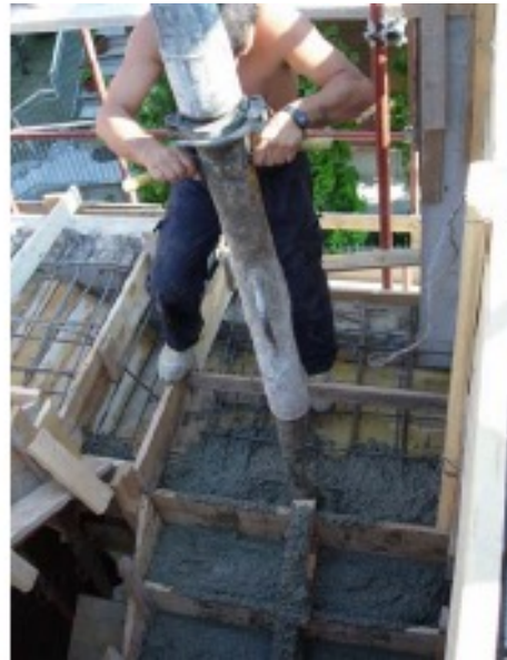
Getto dell'impasto tramite pompa per cls
