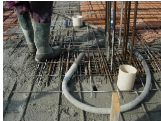
Costipamento dell'impasto nella cassaforma tramite vibratura
