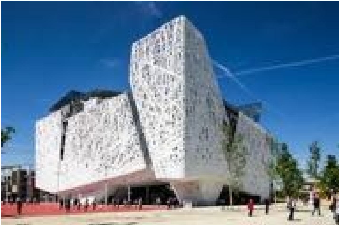
Padiglione Italia Expo, Nemesi&Partners Milano 2015
