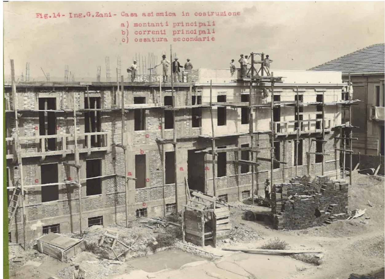
Foto della fase di costruzione e individuazione del parti costruttive della casa asismica economica ancora esistente su Via Georgia, fig. 14 presente nella Relazione della casa asismica di Gino Zani , pag.16
