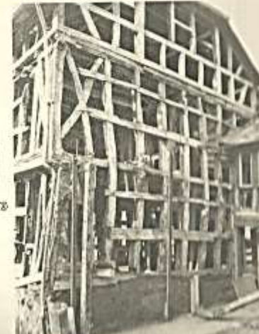
17. Tipi di soluzione dell'ossatura in legno (da H. Walbe, 1954).
