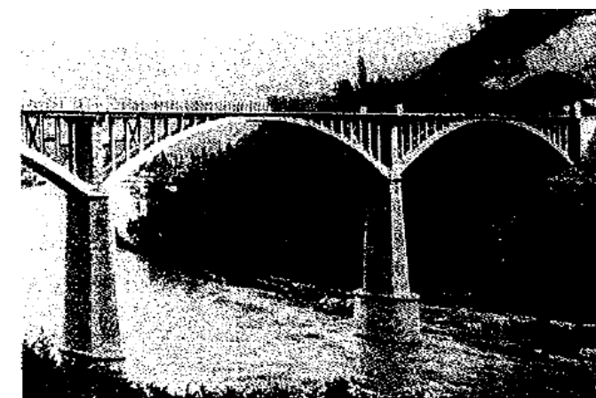
Fig. 4.12: Ponte di Pyrimont a tre archi, 1905 (da: AA.VV. Cent ans de béton armé)
