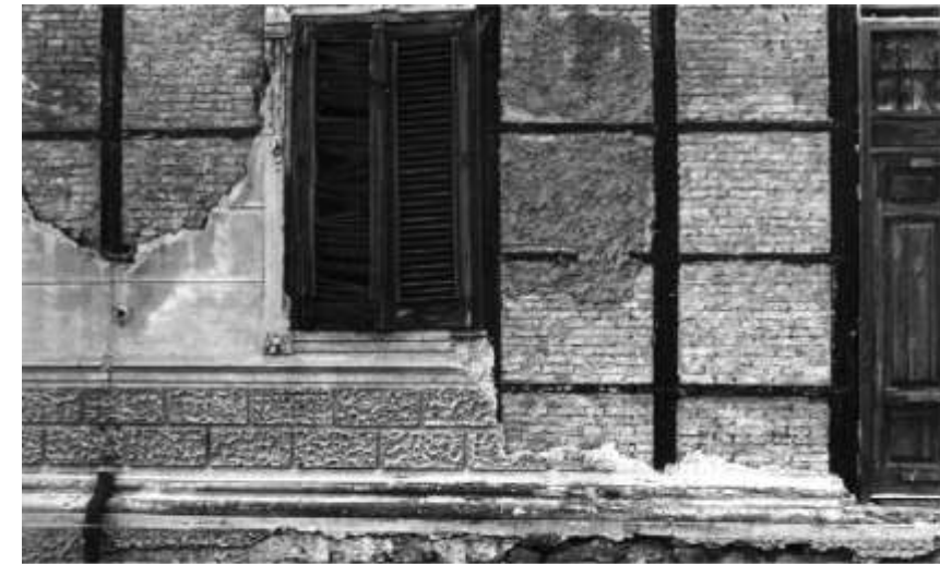
Reggio Calabria, edificio in via Archia (1980), foto dell'architetto Eugenio Galdieri, esperto mondiale di costruzioni in crudo.
