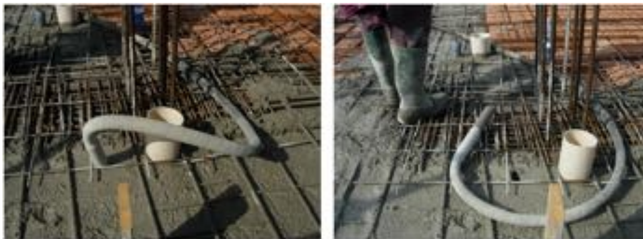
Costipamento dell'impasto nella cassaforma tramite vibratura
