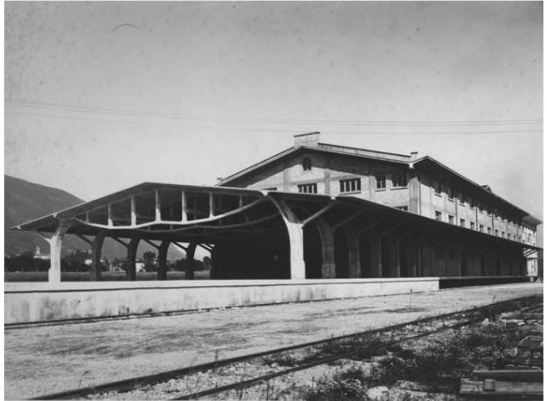
Copertura sul fronte dei Magazzini Generali, Chiasso (TI), Ing. R. Maillart, 1924
