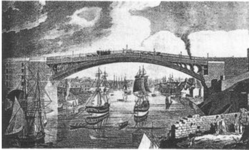
Ponte sul Wear di Sunderland, R. Burdon, 1793-96, L=72 m ghisa e ferro puddellato
