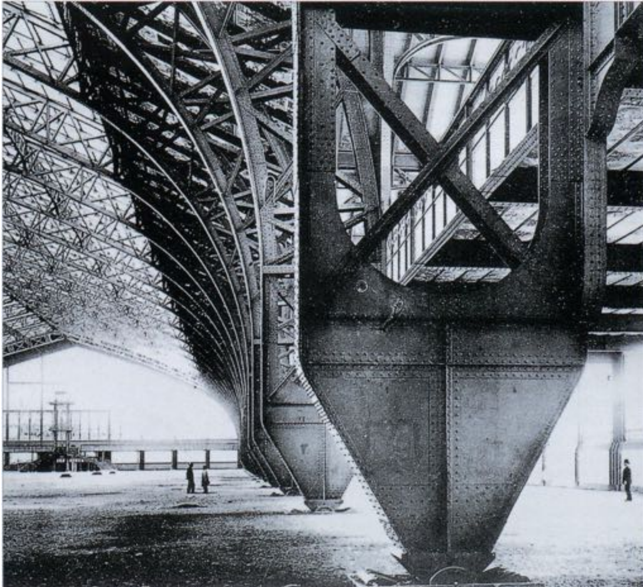
Galerie des Machines, 1889
