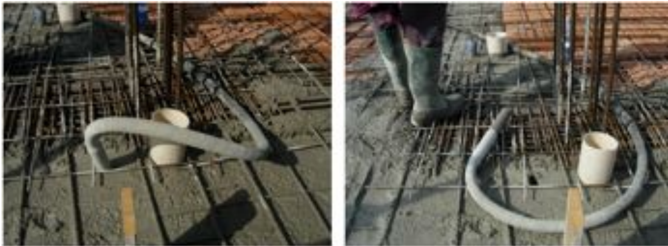
Costipamento dell'impasto nella cassaforma tramite vibratura
