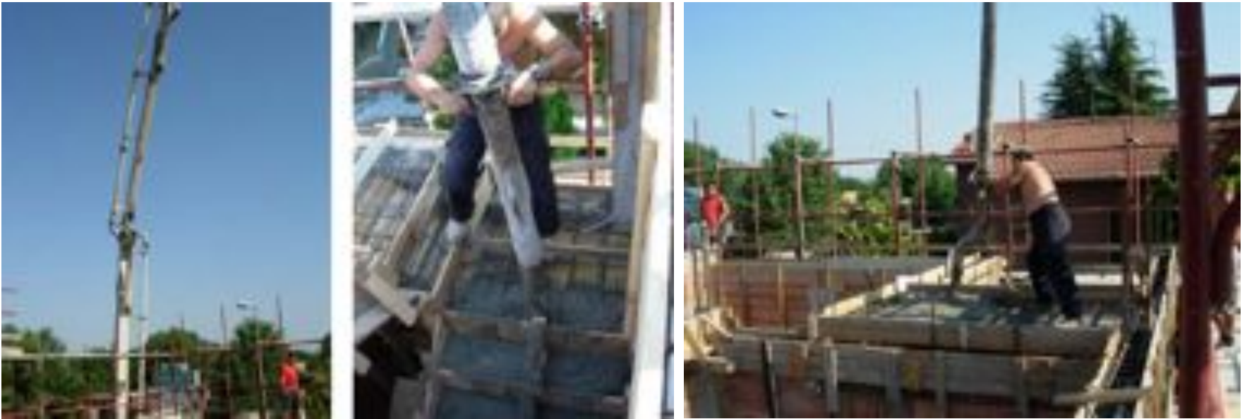
Getto dell'impasto tramite pompa per cls
