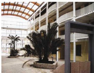
l'atrio tra i due blocchi residenziali trasformato in giardino d'inverno regola le condizioni termo-igrometriche
