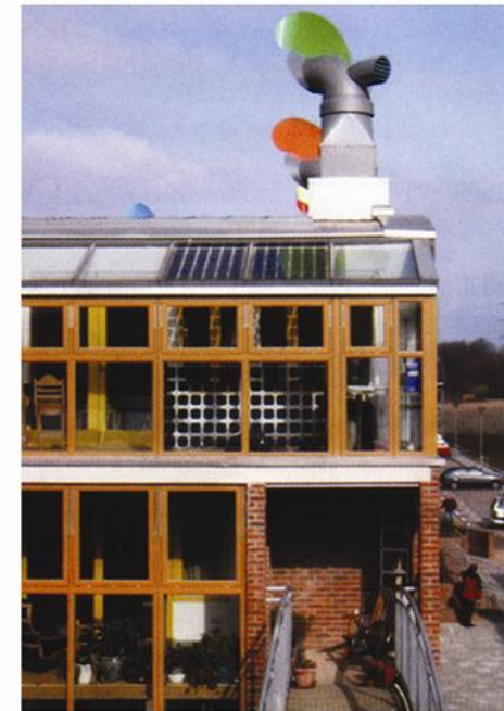
il prospetto sud delle serre su cui sono collocati i pannelli fotovoltaici verticali Elaborato tratto dal lavoro di tesi di Laurea di Valeria Ciulla
