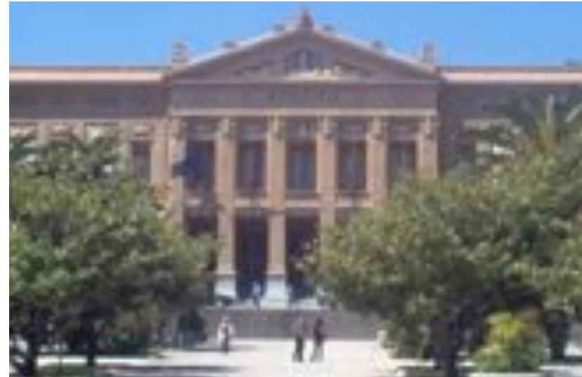
Copertura a timpano
