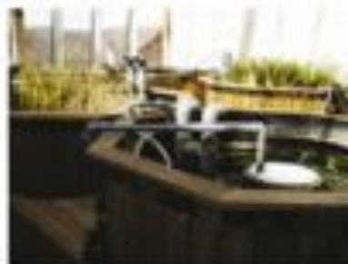
Il sistema Living Machine per il recupero delle acque grigie e nere
