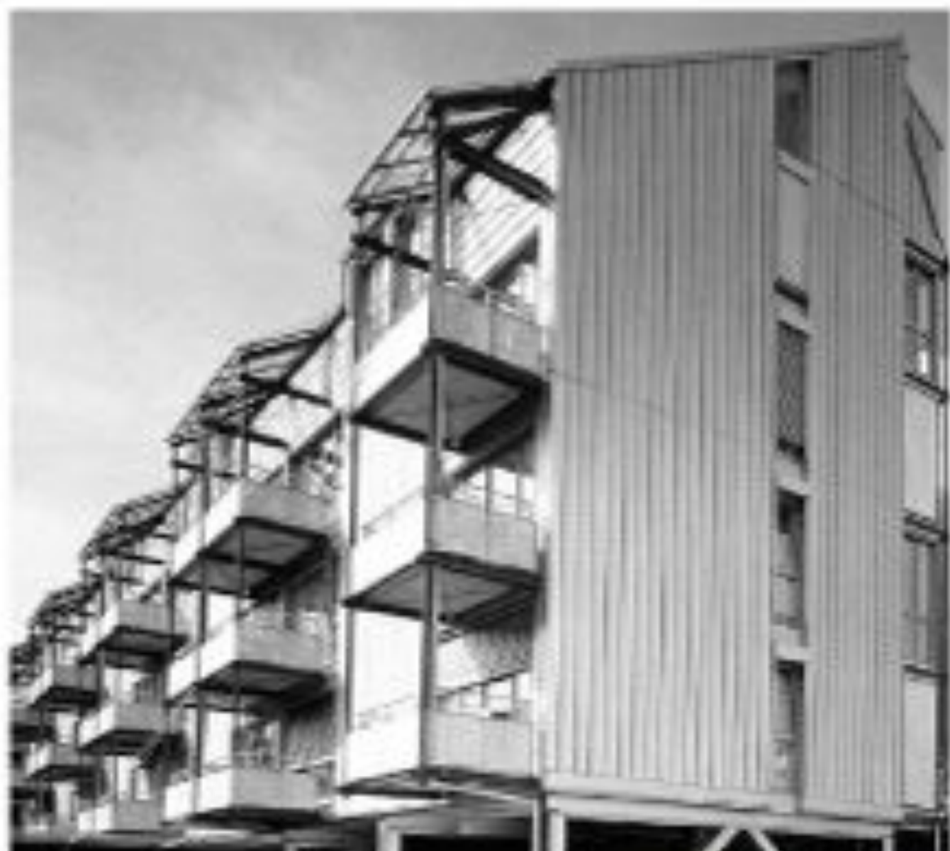
Biehler, Edificio per abitazioni multipiano, Costanza, 1993-95
