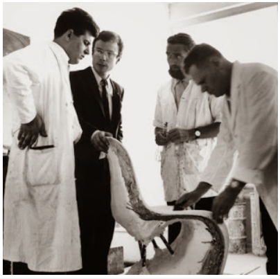
serie di sedie Stacking prodotta in plastica tramite stampaggio ad iniezione famosa per essere la prima sedia realizzata tramite l'uso di un singolo stampo.
