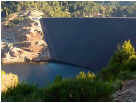
Figura 2 – La diga sul Menta (RC) (Fonte: Incarnato, 2017)
