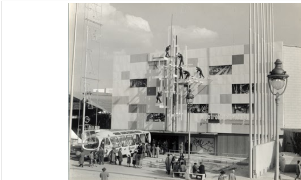
1954 padiglione Eni facciata esterna. Progetto Erberto Carboni.
