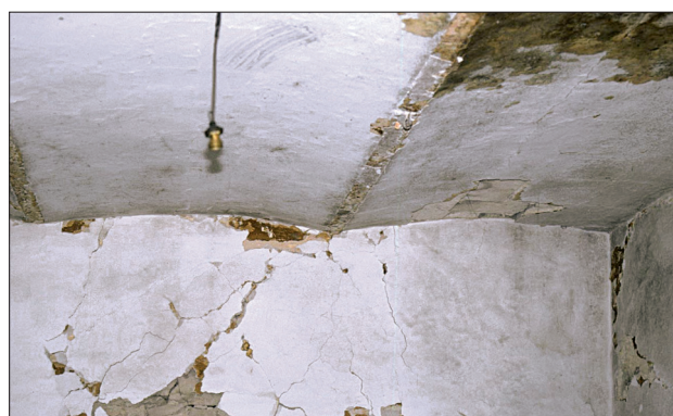
Solaio con travi di ferro a voltine.
