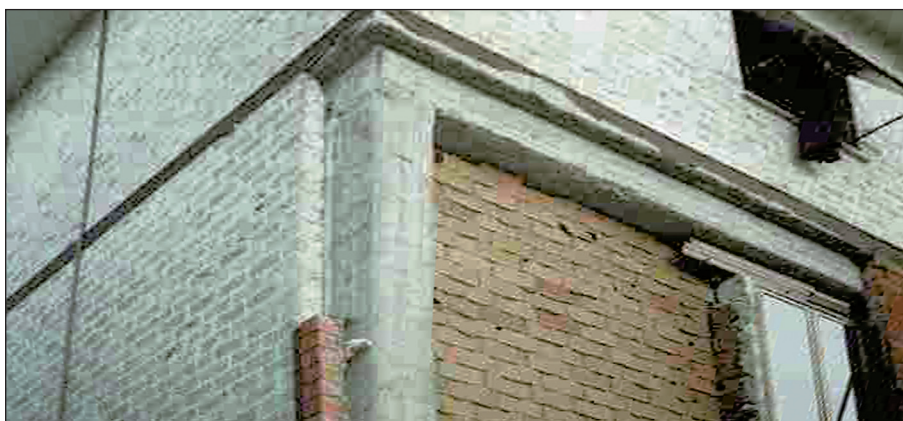
Figura 10. Esempio di dissimmetrie delle tamponature (Manuale AeDES).
