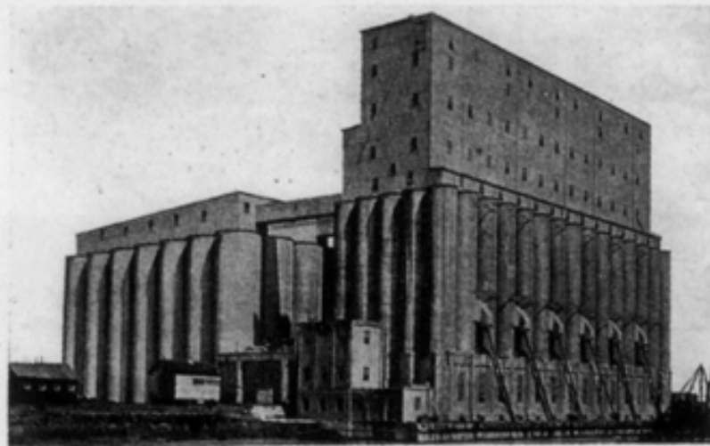
GETREIDESILO UND ELEVATOR
