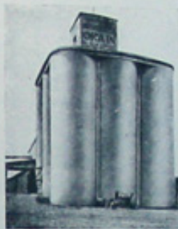
Silo à grains.
