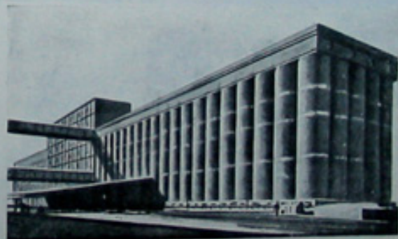
Silos et évaporateurs à M e au Canada.
