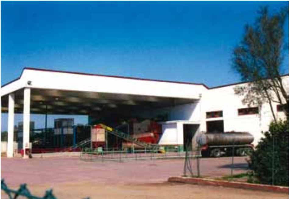
Figura 4 – Tettoia sopra vasca di scarico delle olive
