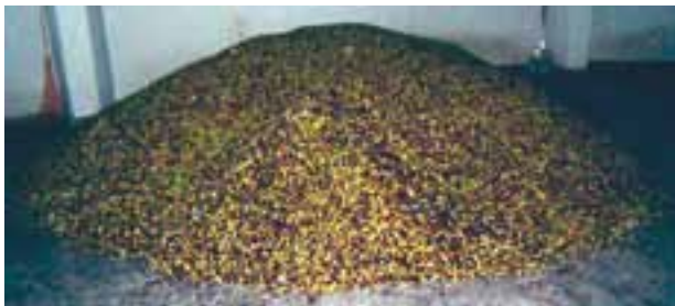
Figura 7 - Cumulo di olive su strato di finitura in resina alimentare (da notare lo stato di degradazione della pavimentazione)
