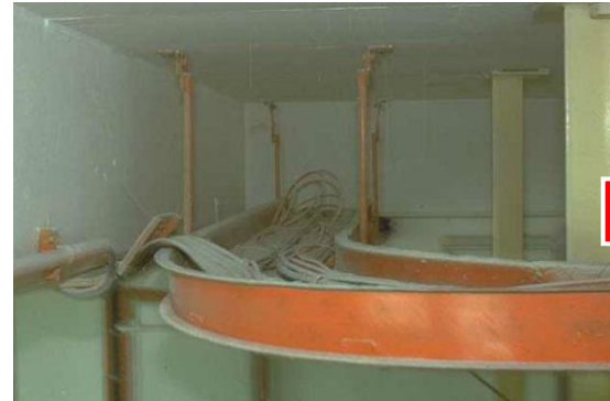
ACCUMULO DI POLVERE SU CANALINA IMPIANTO ELETTRICO
