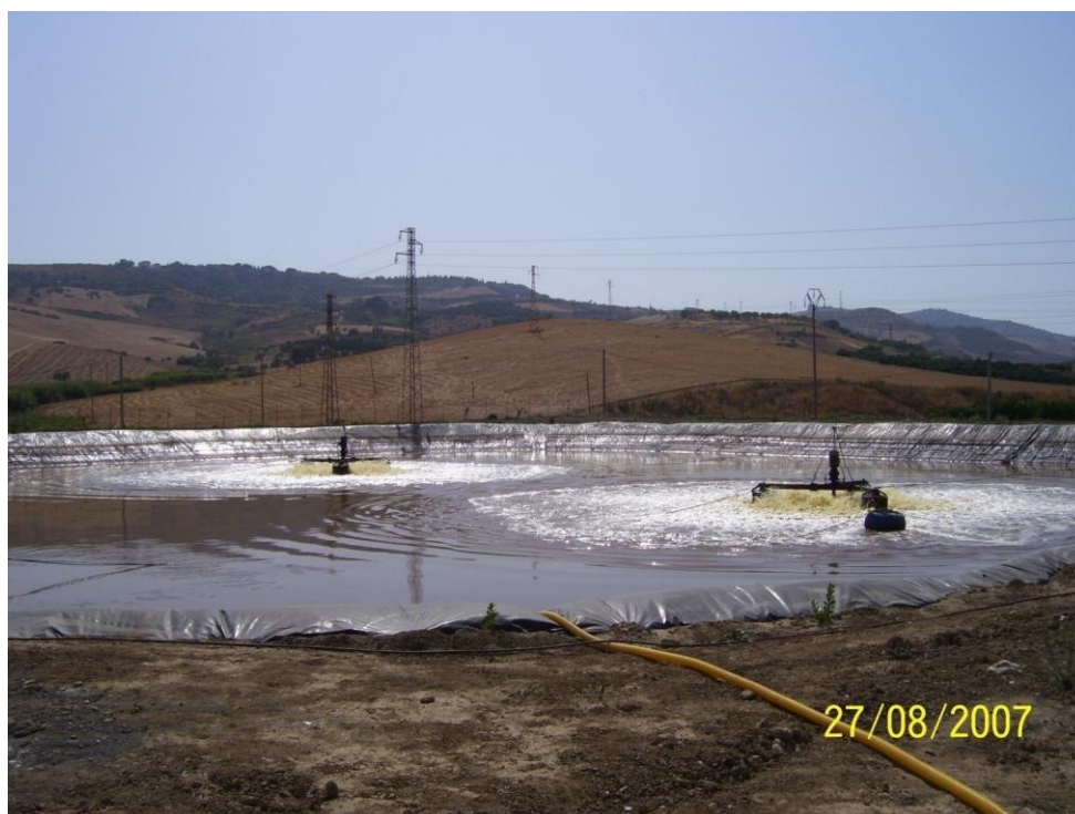
Una laguna aerata per il trattamento dei reflui agrumari in Sicilia
